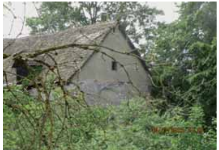
Schlossstadel von Ost – der untere Teil ist die Originalmauer mit dem Fenster des „Rittersaales“
