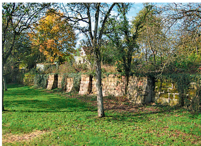
Die denkmalgeschützte Sandsteinmauer im Schlossgraben soll 2015 saniert werden
