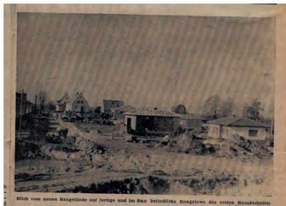
Blick vom neuen Baugelände auf fertige und im Bau befindliche Bungalows des ersten Bauabschnitts. Aufnahme: Kroll
