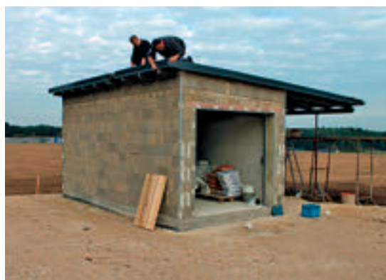
Thomas Knogl und Bruno Henning bei den Restarbeiten am Dach des Technikhauses
