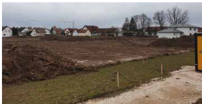
Die Bauarbeiten für die Erschließung von 19 Wohnbaugrundstücken im Baugebiet „Kleewiese“ in Rengersricht haben zwischenzeitlich begonnen.
