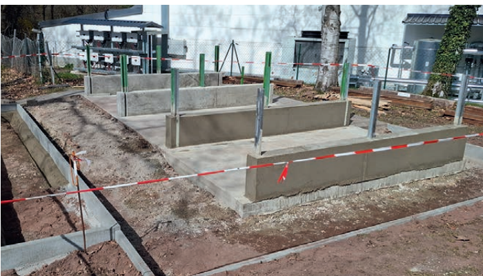
Am Friedhof in Pyrbaum Splittbox errichtet
