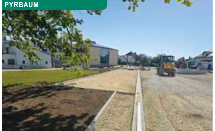
Außenbereich der Schule wird angelegt
