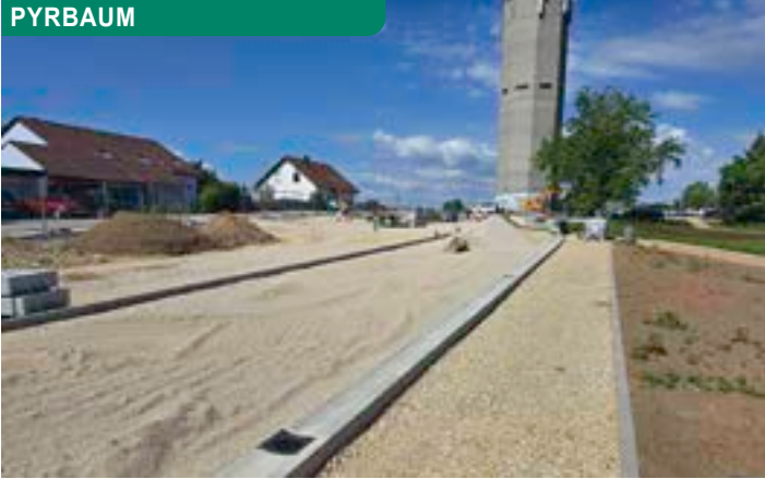
Außenbereich der Schule wird angelegt
