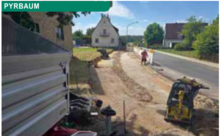
Bushaltestelle Kurpfalzstraße wird gebaut
