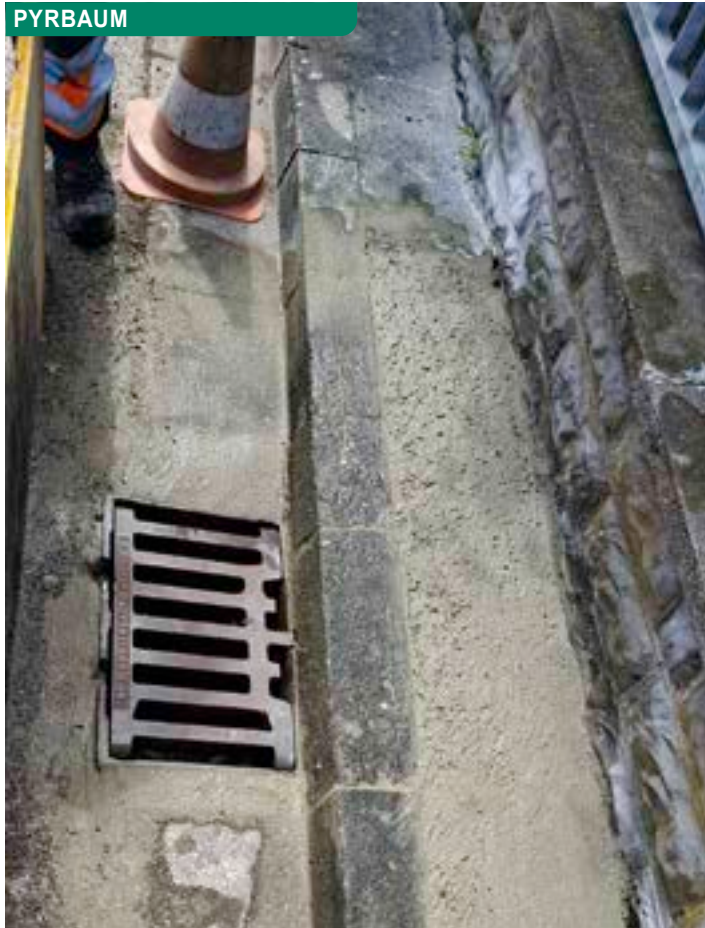
Reparatur des Sinkkastens
