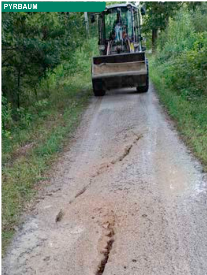
Risse – durch Trockenheit – am Bahndamm ausgebessert
